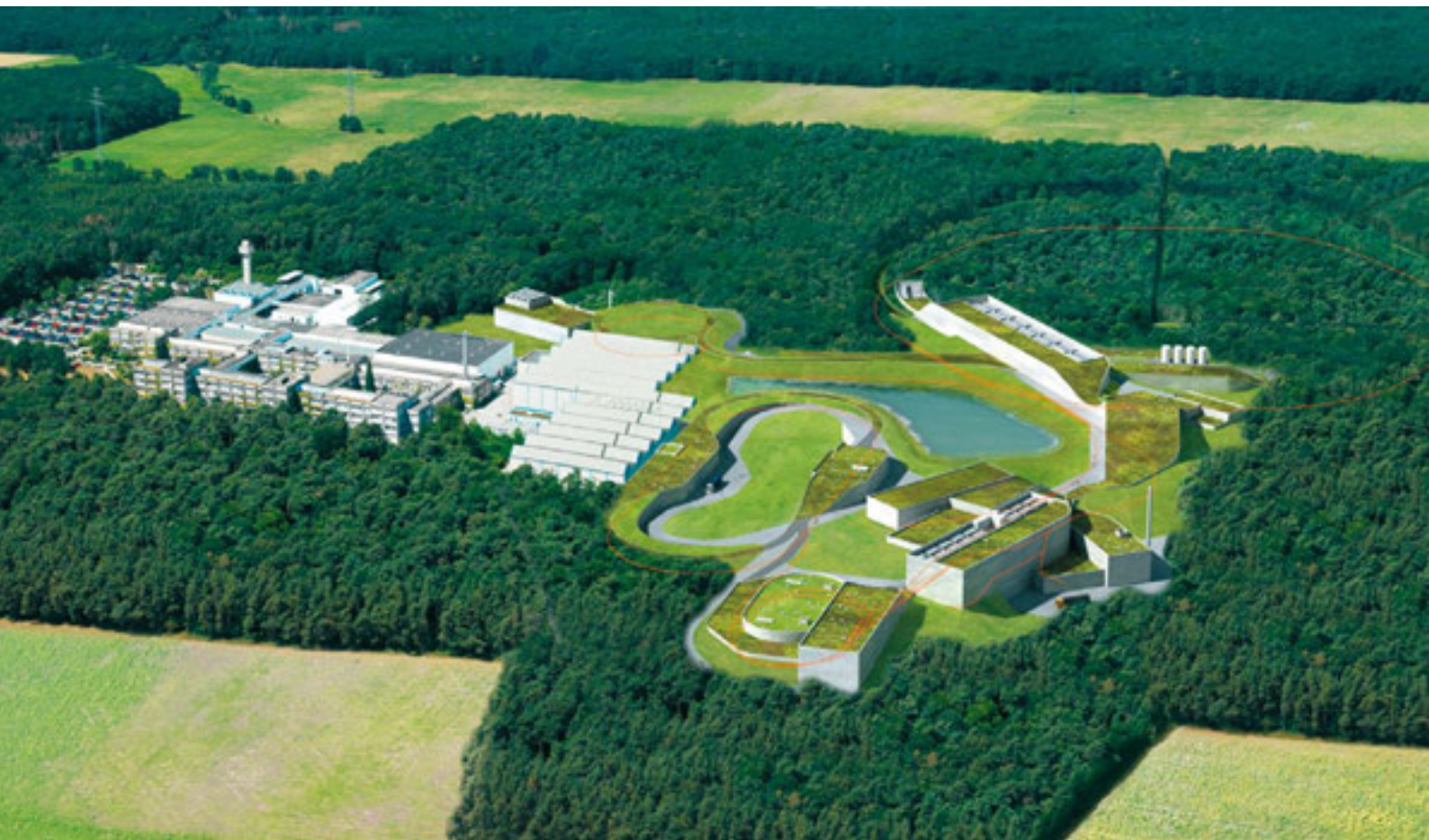
GSI-FAIR Fotomontage der im Bau befindlichen Anlage GSI-FAIR Photomontage du centre de recherche en construction
