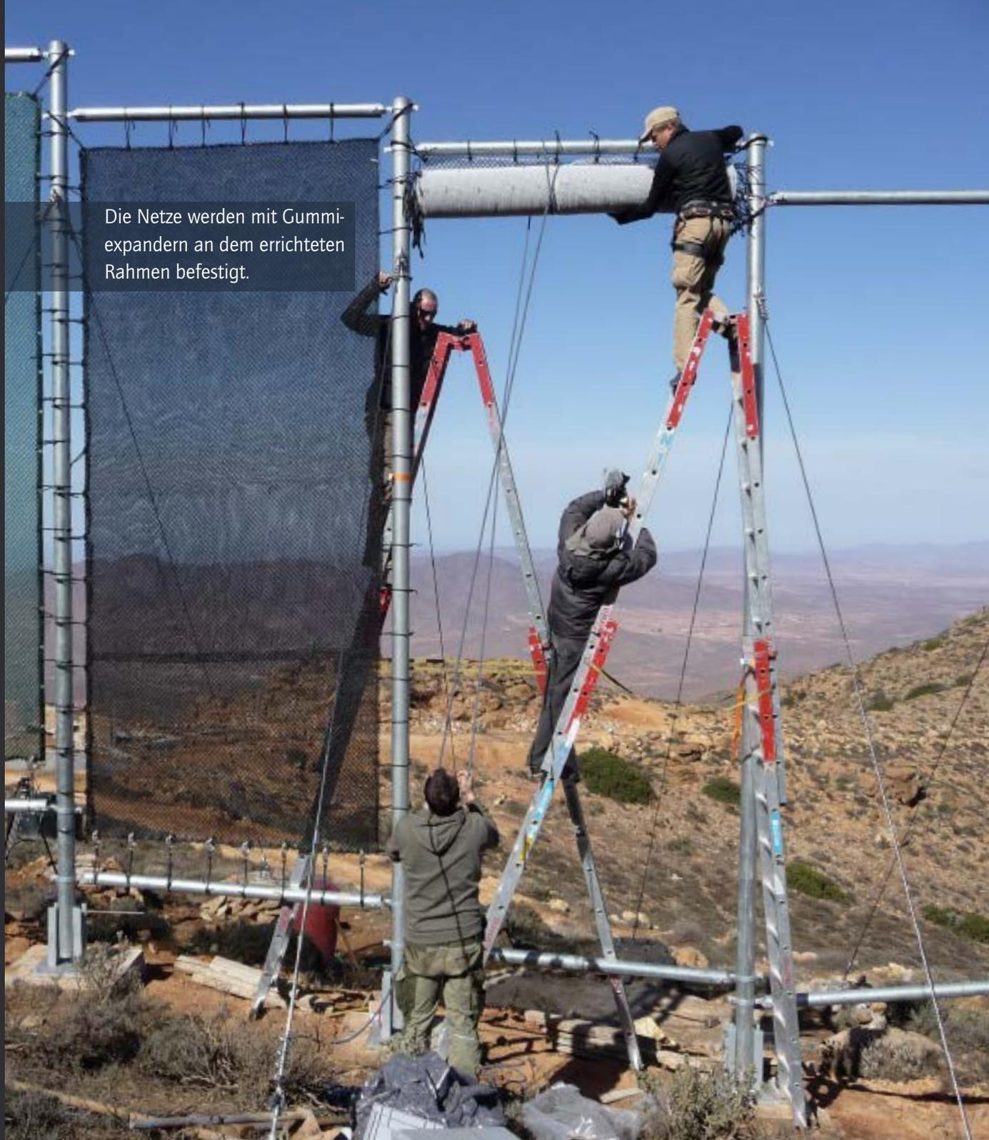
Die Netze werden mit Gummiexpandern an dem errichteten Rahmen befestigt.
