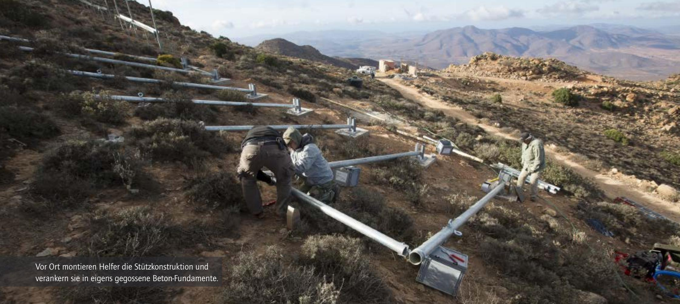
Vor Ort montieren Helfer die Stützkonstruktion und verankern sie in eigens gegossene Beton-Fundamente.
